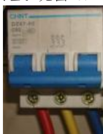
图 9.1 空气开关
